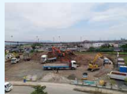
杭打ち前に、すき取り作業（土地の表面を削り取る作業）を行っている写真です
